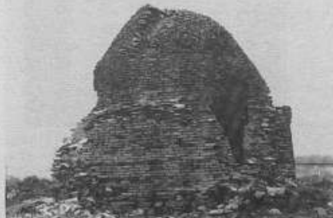
Жубан-Ана. Вид с юго-восточной стороны
