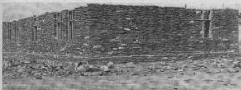
Недостроенный современный казахский дом из камня-плитняка
