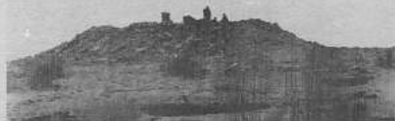
Полуразрушенный дынг на р. Атасу
