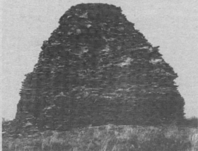
Домбаул. Вид с запада
